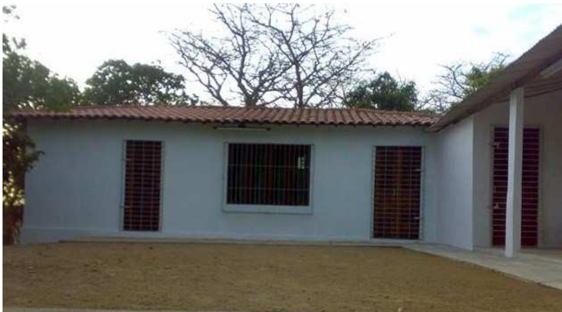
Foto 4. Refeitório junto ao templo. Direito de imagem cedido pela SEUDV Foto: Wagner Lira.
